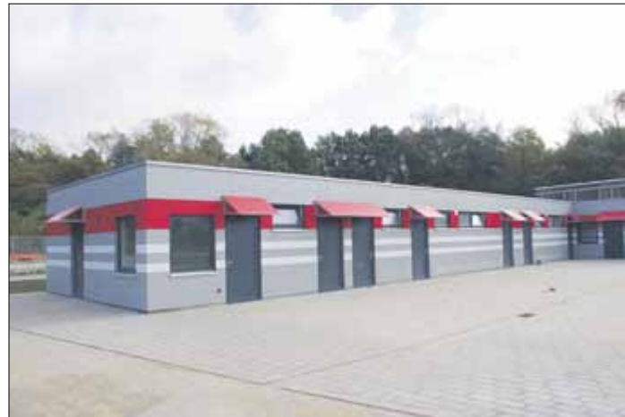
Die neuen Umkleiden sind schon fertig.
