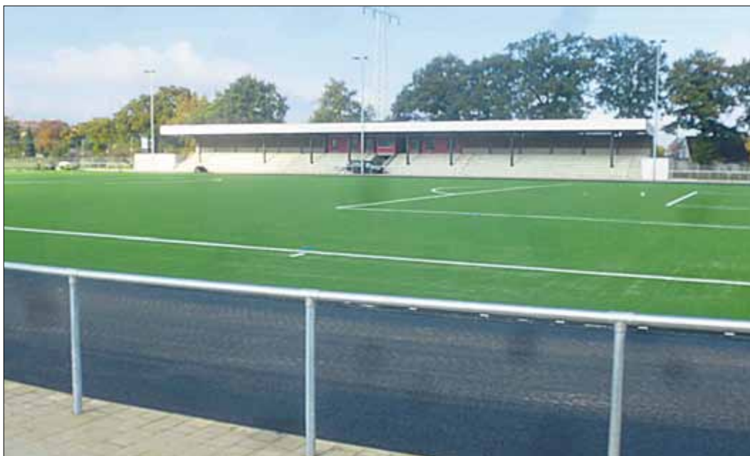
Strahl schon im neuen Stadion am Vorhornweg: Die neue Tribüne des SV Lurup
