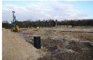
Ein Blick auf die Baustelle am Vorhornweg.
